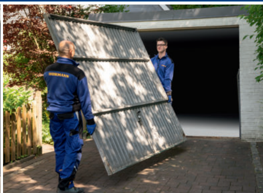
Ausbau und umweltgerechte Entsorgung
